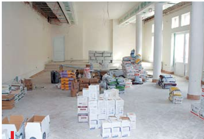
Nowa kaplice w stanie surowym
